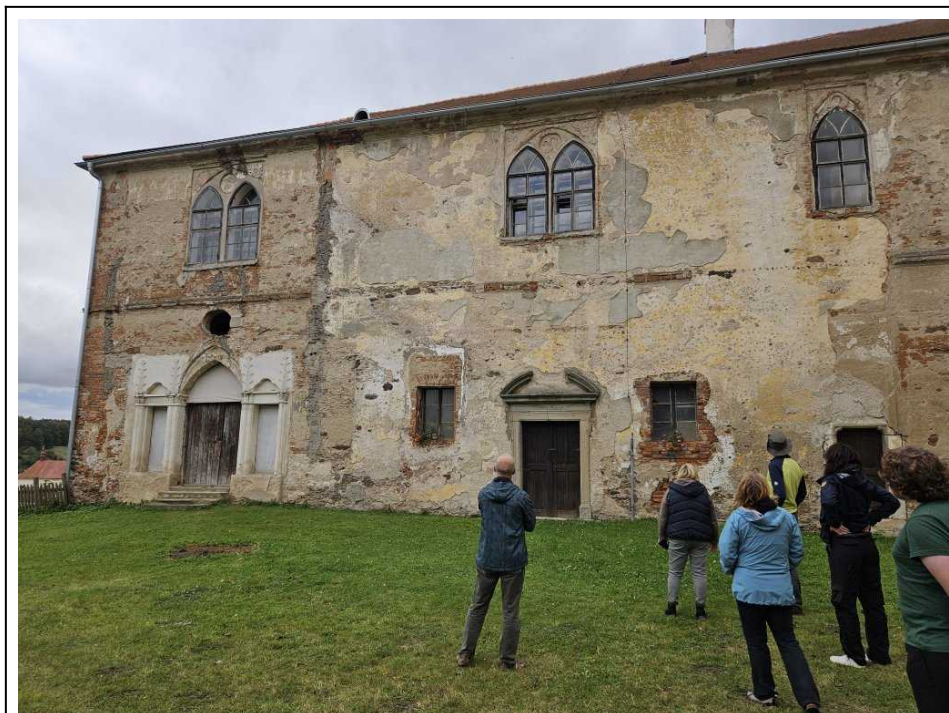
Zámek Brtnice potřebuje důkladnou rekonstrukci
