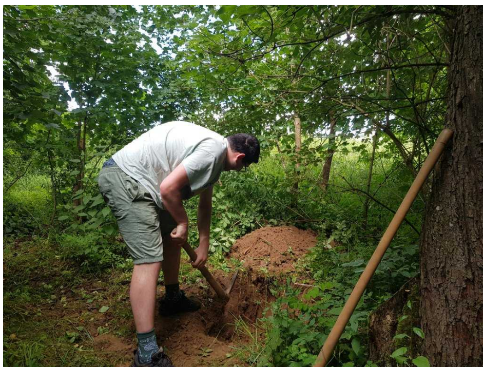
Mikuláš zahajuje výkop odpadovky
