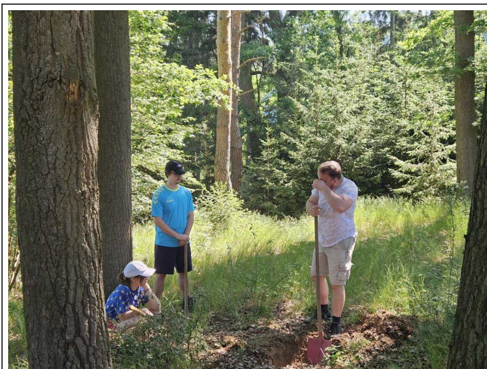
Adam a Piškot zahajují výkop odpadovky
