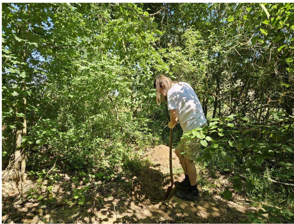
Tady je Tomáš kousek po zahájení výkopu odpadovky
