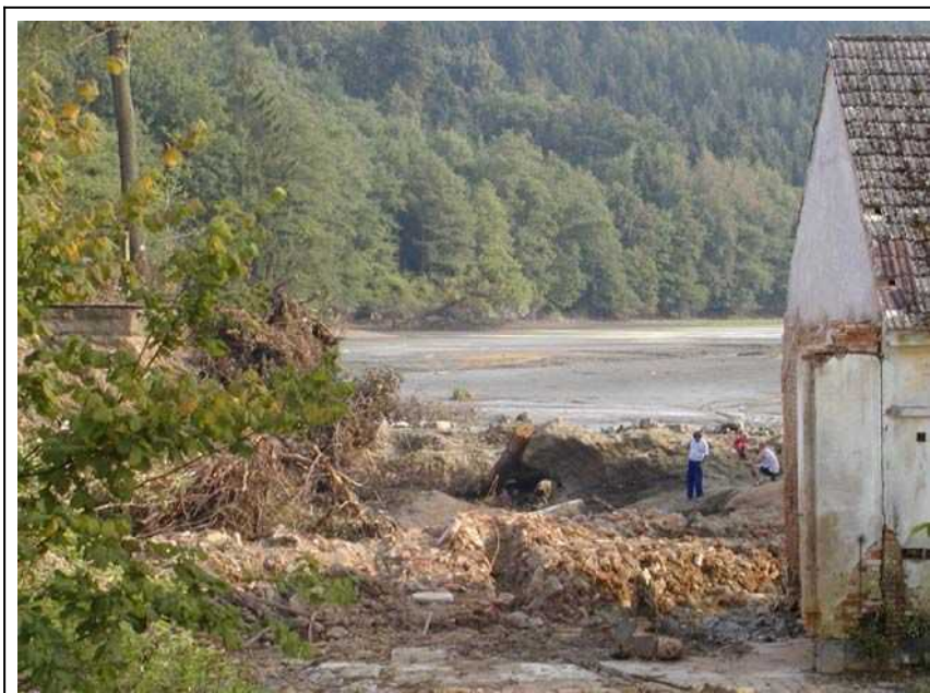
Protržená hráz po povodni.
