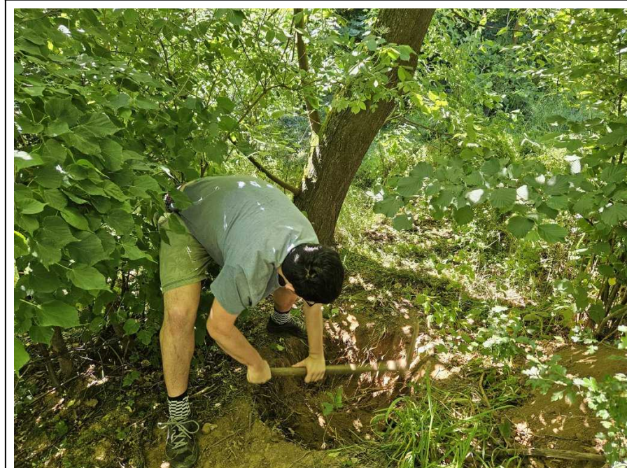
Mikuláš začíná hloubit odpadovku
