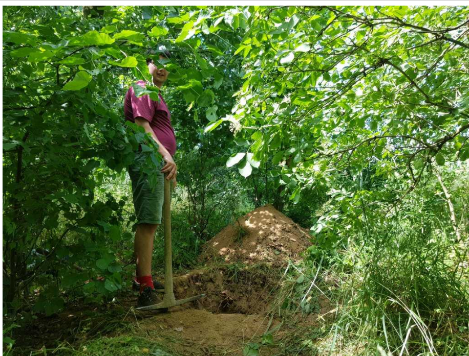
Mikuláš skrytý v listí u výkopu odpadovky
